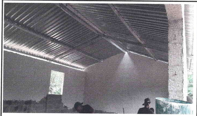
Foto 2: mejoraamiento de lamina calibre 26
