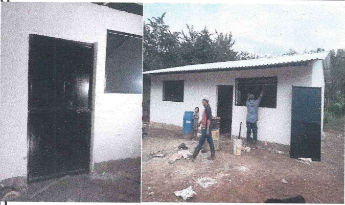
Foto 1: mejoramiento de puerta y las ventanas
