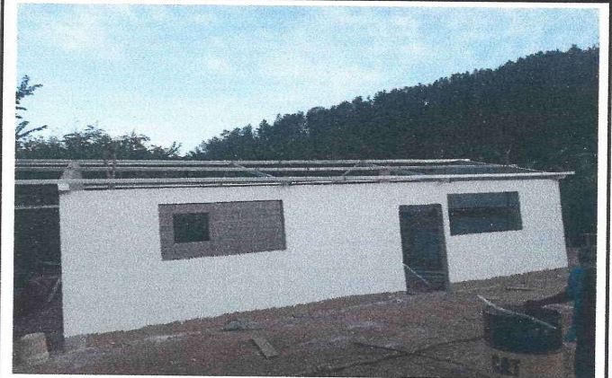
Foto 4: mejoramiento de estructura por falta de lamina
