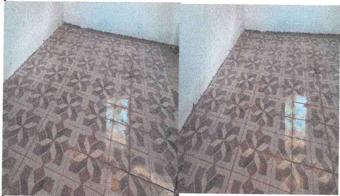
Foto 3: mejoramiento de piso ceramico
